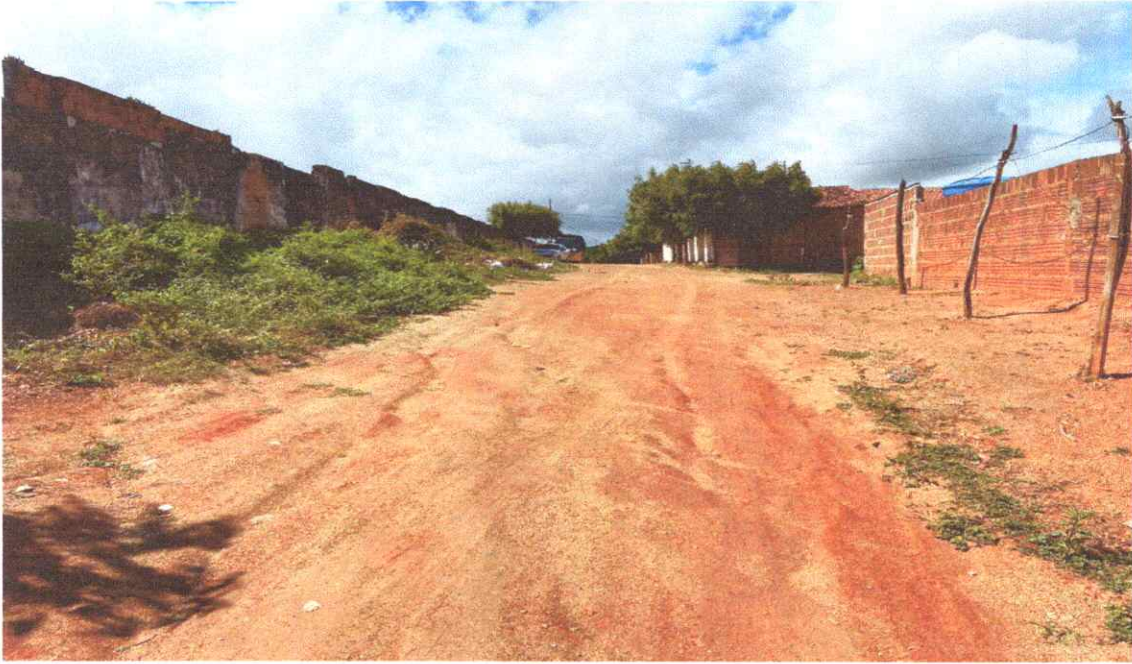
Imagem 04: Rua José Rodrigues Duarte, Bairro Macapá II Arquivo Autor - Data: 05/06/2024
